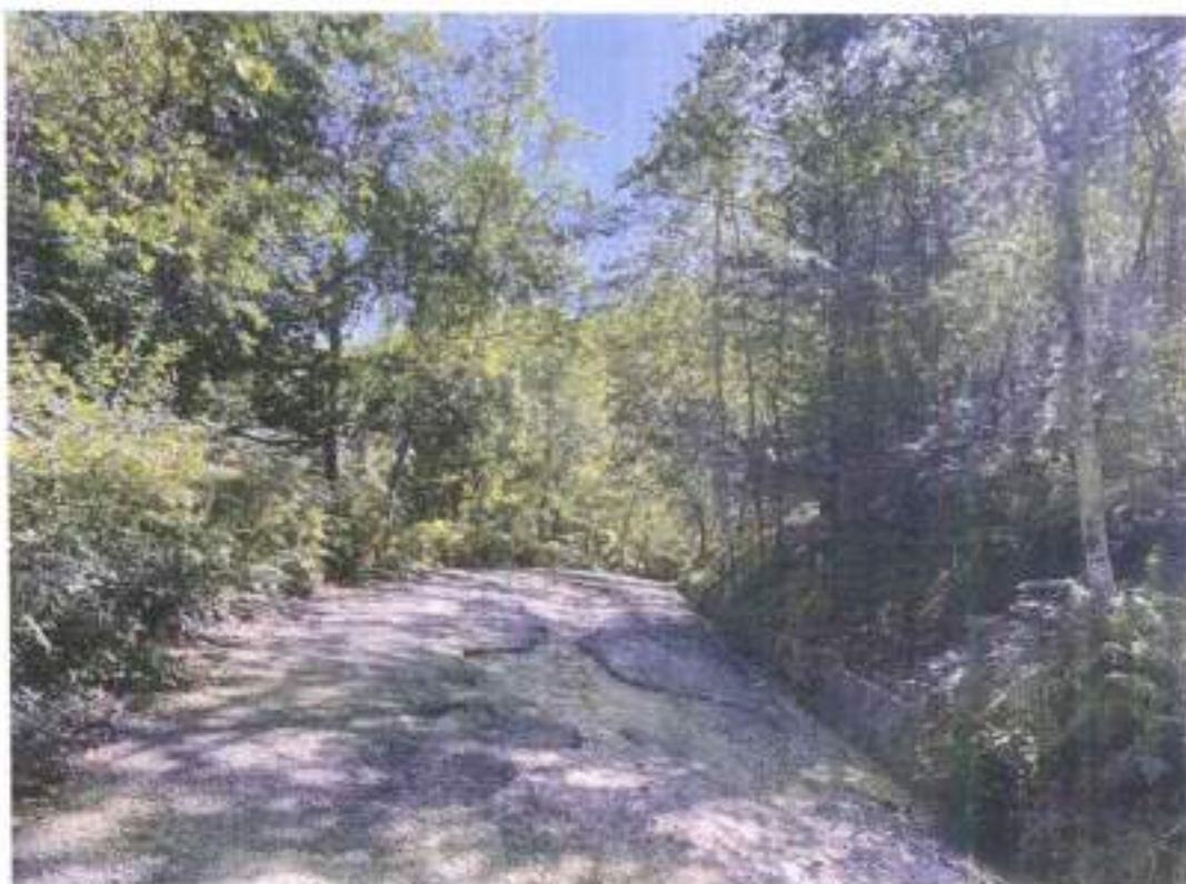
Foto 2 – particolare dissesti manto stradale
